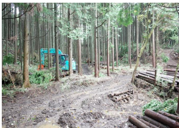
写真：路網（作業道）の開設状況
