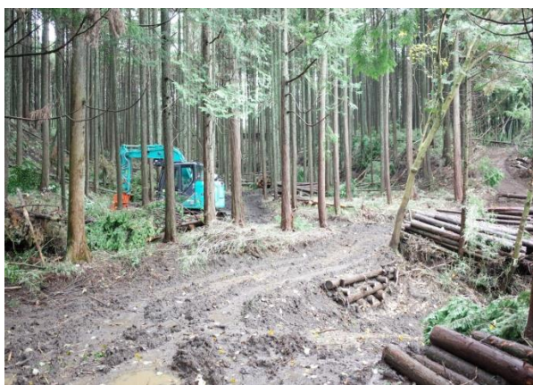
写真：路網（作業道）の開設状況
