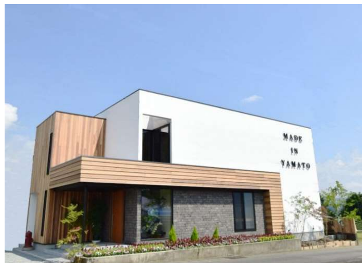
大和建設株式会社 新社屋
