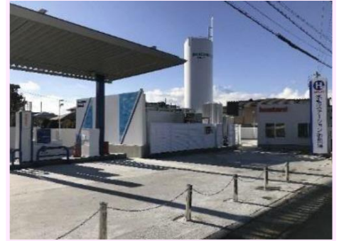
② 水素ステーション
