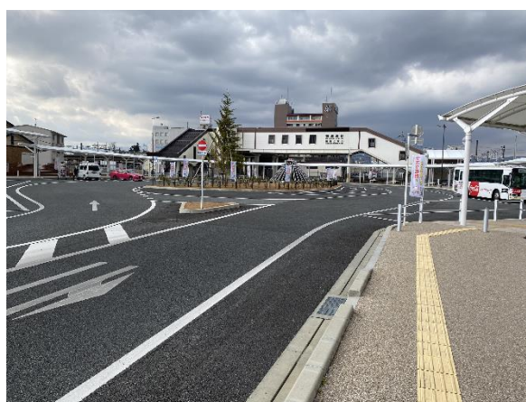
整備された御殿場駅箱根乙女口
