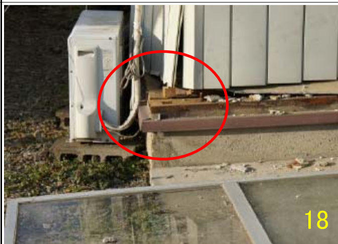
L 2 柱の抜け出し（多数の場合 L 3）
