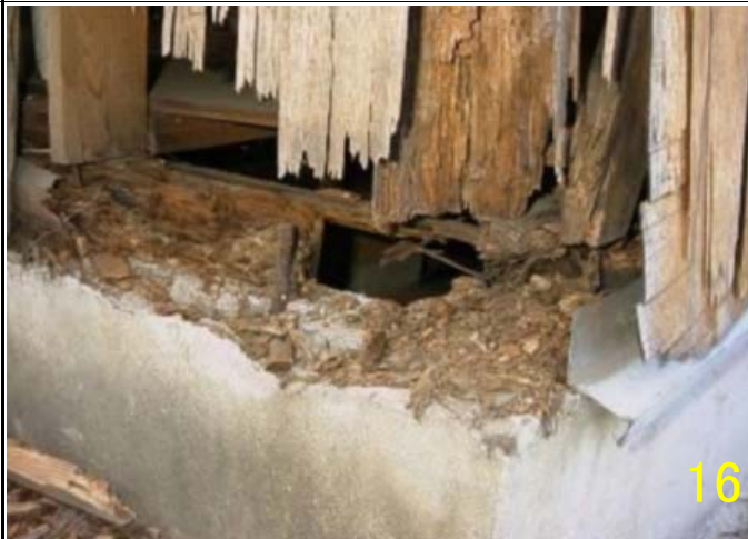
L 2 柱の抜け出し（多数の場合 L 3）
