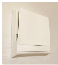
壁の換気口例
