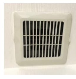
天井の換気口例
