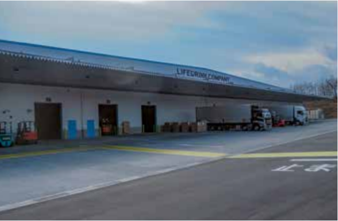
▲地域産業立地促進事業（飲料水製造工場）
