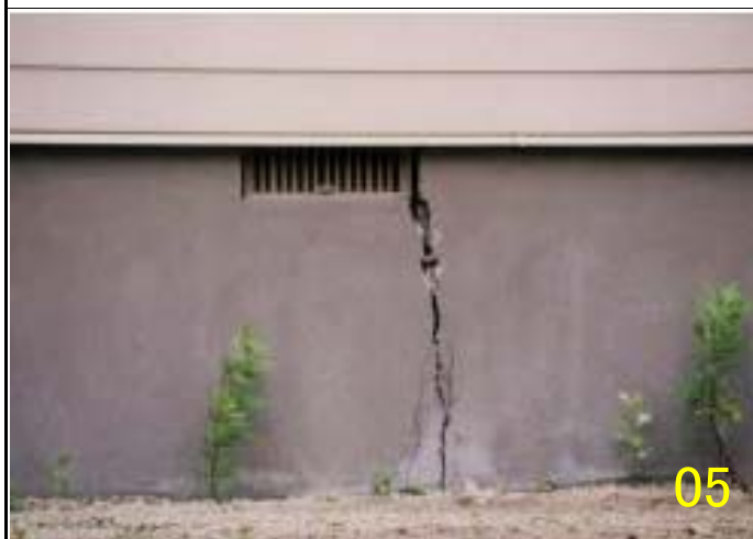
L 2 基礎の鉄筋の露出、コンクリートの欠損、モルタルの剥離 (広範囲にわたる場合 L 3)
