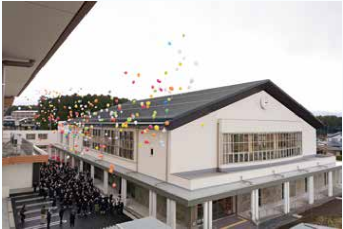
▲西中学校校舎改築事業（西中学校屋内運動場）
