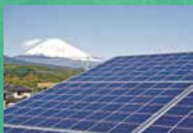
▲裾野市庁舎の太陽光パネル
