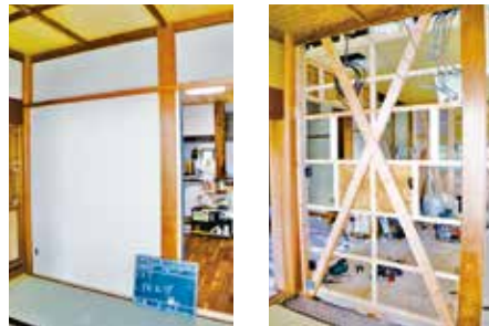
補強工事中 ← 補強工事完了
