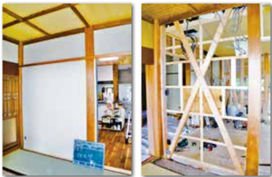
▲補強工事完了
