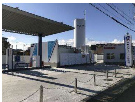
市内に誘致した水素ステーション
