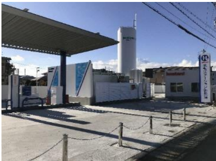
市内に誘致した水素ステーション
