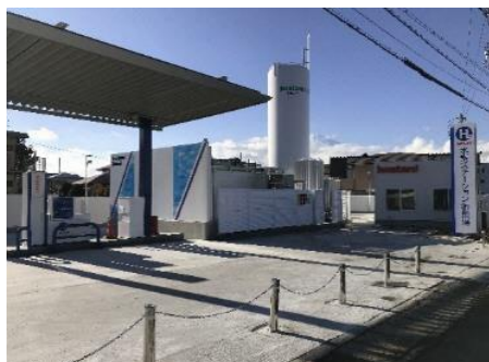
市内に誘致した水素ステーション
