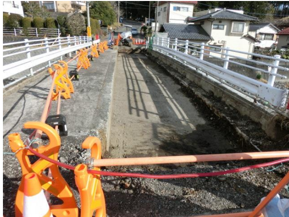
現場状況（橋面）
