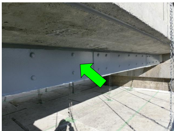
上部工・塗替え塗装工
