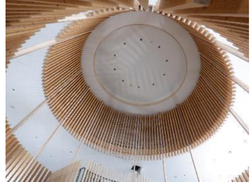
写真-3 木製ルーバー真下から 吹き抜け天井方向を見上げる
