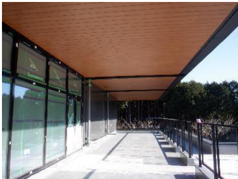
写真-4 屋外デッキ (南側)
