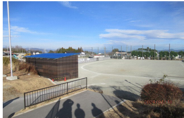
グラウンド(工事で未使用部分バリケード有)
