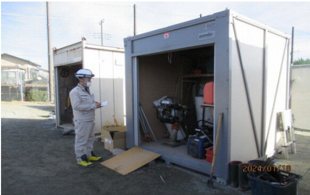
現場資材置場
