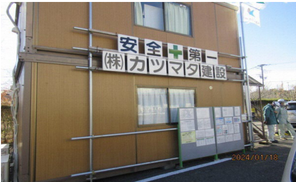
現場工事事務所及び建退協等業法関係揭示看板
