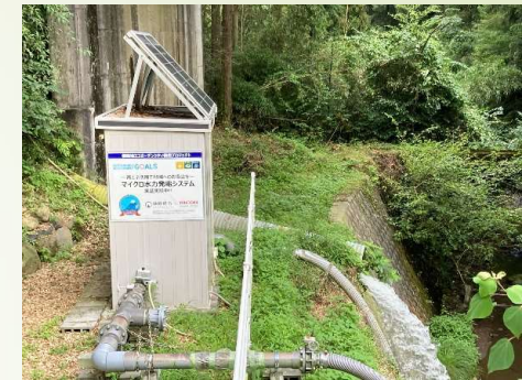
御殿場市二子の実証実験箇所の様子
