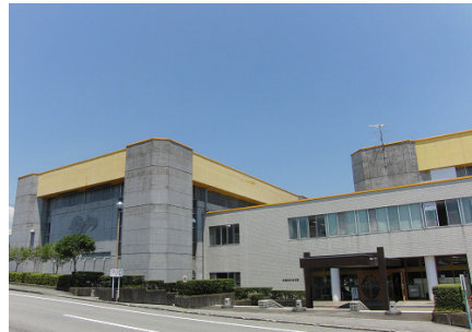
市体育館(アリーナ・格技場ほか) ※全面改修工事H29秋～
