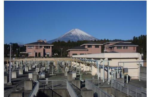
▲御殿場浄化センター
