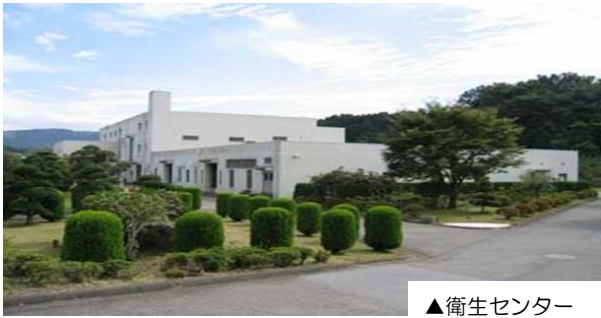
▲衛生センター
