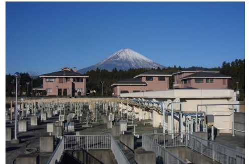
▲御殿場浄化センター
