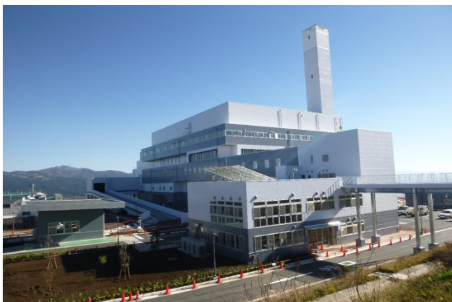
↑富士山エコパーク内に建設された焼却センター
