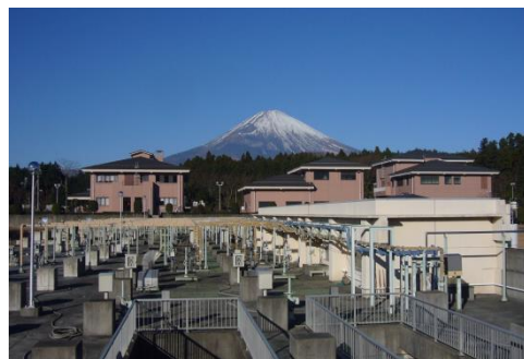
▲御殿場浄化センター
