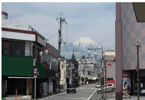
県道御殿場停車場線 無電柱化前
