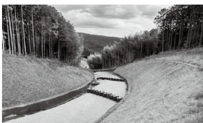
神山深良線第1工区
