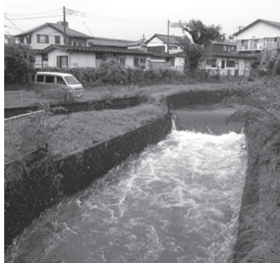
雨で増水する黄瀬川(新橋区)
