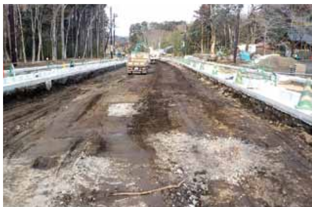
御東原循環線(東山地先)道路改修工事
