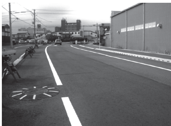
御殿場駅箱根乙女口線の様子
