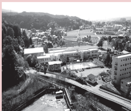
広域道路(仮称)神山深良線計画地域の景観 【中央の建物は神山小学校】
