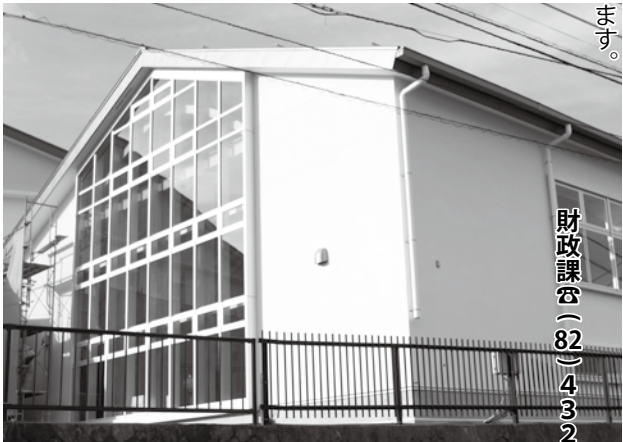
▲工事中の玉穂地区児童屋内体育施設
