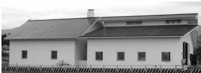
▲平成 24 年 3 月完成の「御殿場第一中継ポンプ場」
