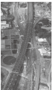
▲御殿場JCT付近
