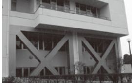
▲耐震補強をした会議棟外観
