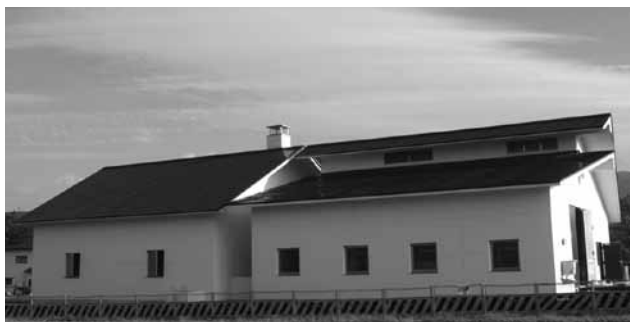
▲平成 24 年 3 月完成予定の「御殿場第一中継ポンプ場」
