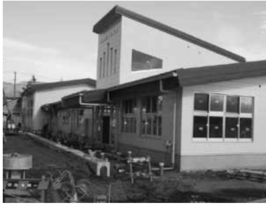
▲ 改築工事が進む原里第 1 保育園
