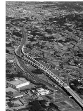
▲工事が進む新東名高速道路
