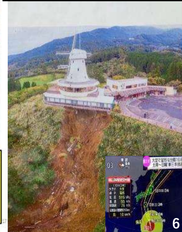
台風19号：R1.10.12 大雨被害
