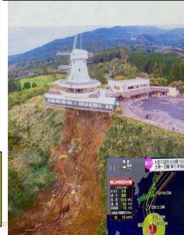
台風19号：R1.10.12 大雨被害
