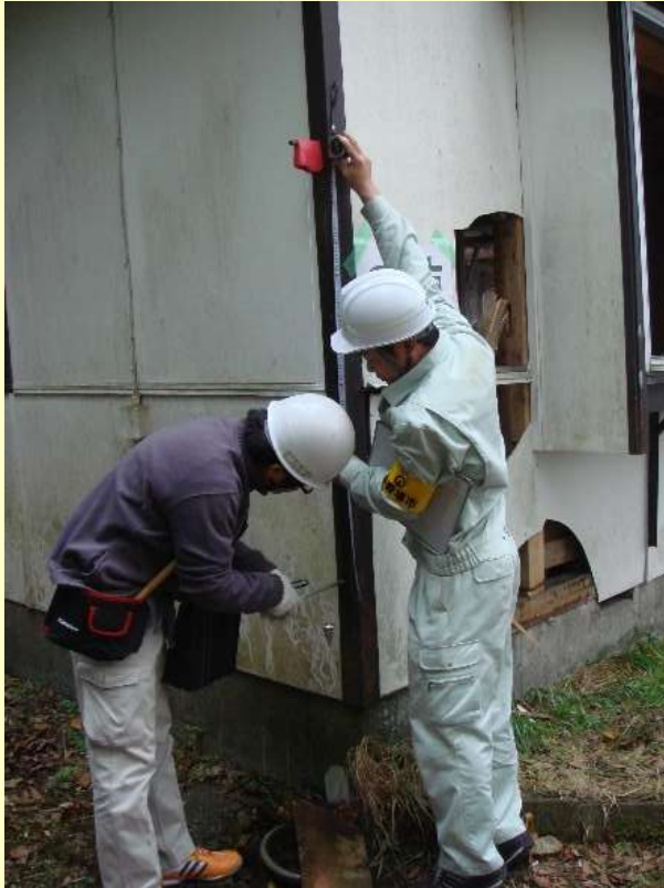
▲被災建物の傾き計測
